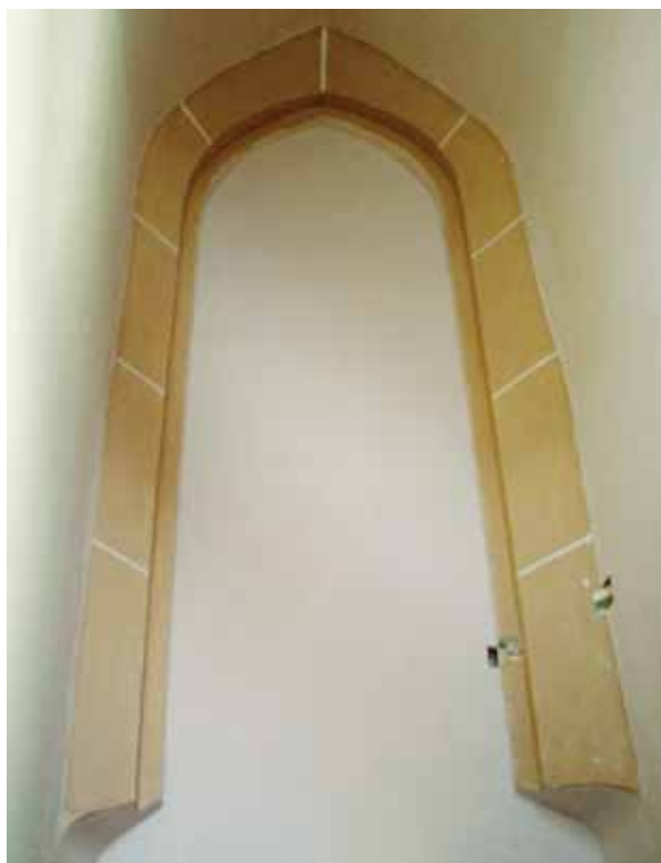
10. A nyugati homlokzat befalazott ablaka
