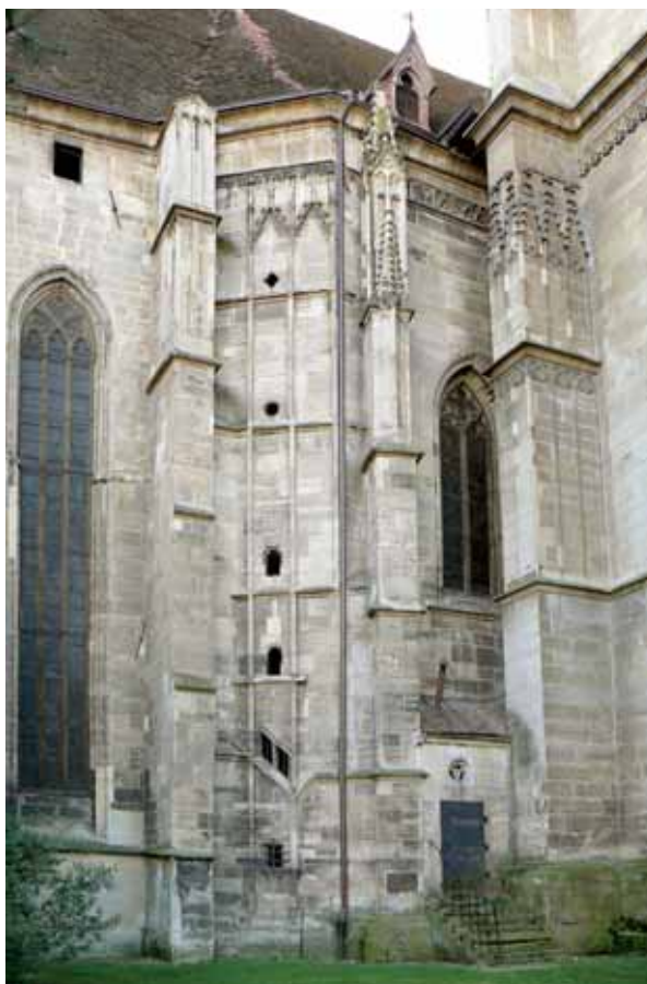
10. Kolozsvár, Szent Mihály-templom. A hajó északkeleti sarkának kettős csigalépcsője északról
