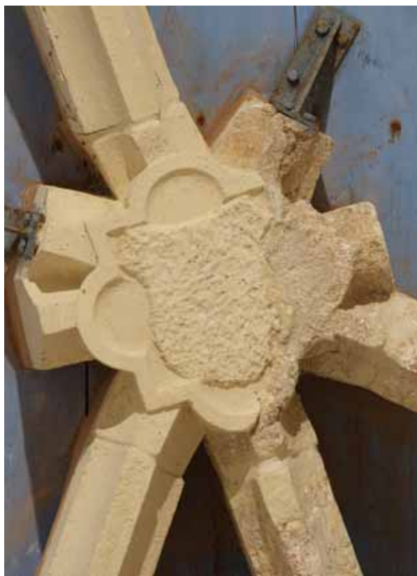
10. A szentélyboltozat kiegészített záróköve
