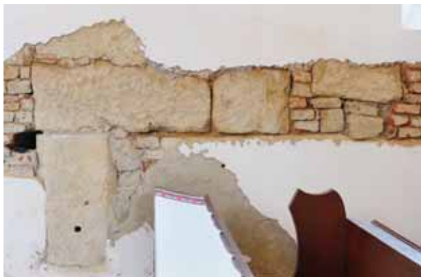
18. Gacsály, református templom. Falazókőként felhasznált kőfaragványok a déli hajófalban
