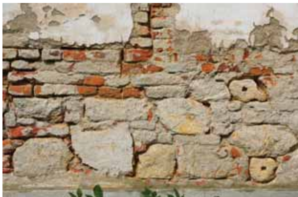
10. Gacsály, református templom. Másodlagosan felhasznált kőfaragványok a déli hajófalban
