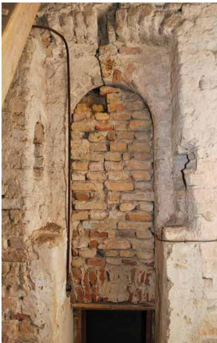
2. Szakoly református templom. A nyugati homlokzat kapu feletti, befalazott ablaka a toronybelsőben
